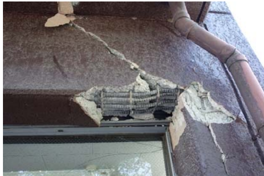
梁の損傷 (熊本地震2016)
