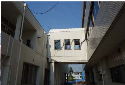
渡り廊下の損傷 (熊本地震2016)
