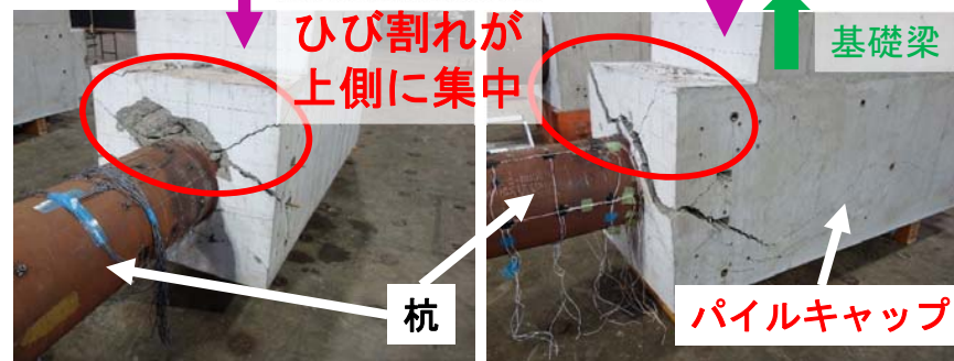
図 最終破壊状況No.1
