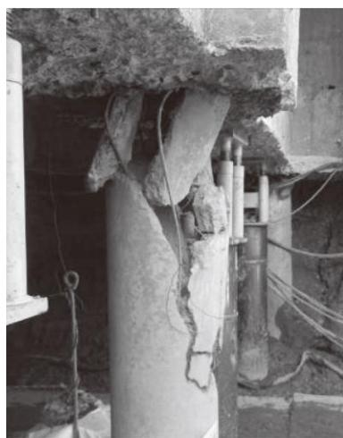
写真1 杭の破損※
