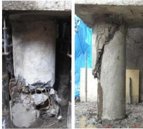
図1 熊本地震でのPHC杭の損傷被害（金子治）
