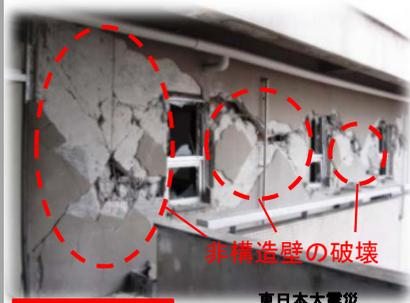
東日本大震災では非構造壁の損傷が激しく、架構の倒壊に対する耐力は、十分確保されていたにもかかわらず住民は避難を余儀なくされた。
