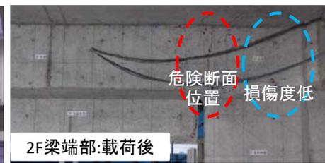
柱梁接合部に損傷は見当たらず、またひび割れがスリット付近に集中していることから危険断面位置も柱フェイスから袖壁端部へと移動していることがわかる。
