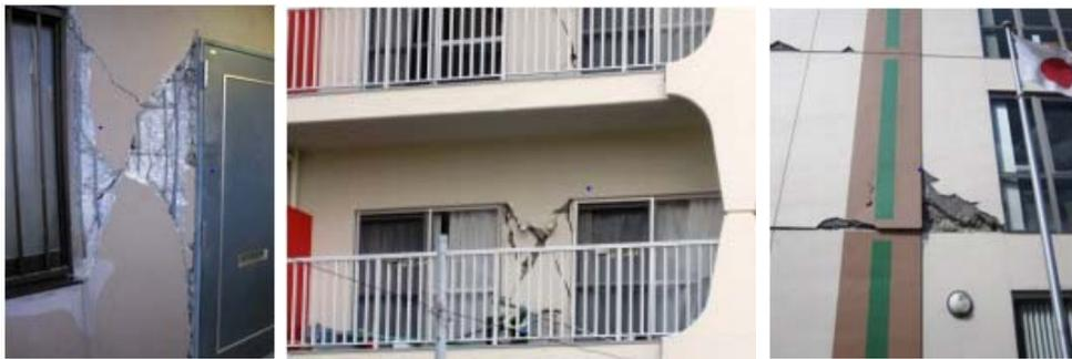
写真: 東日本大震災の被害状況
