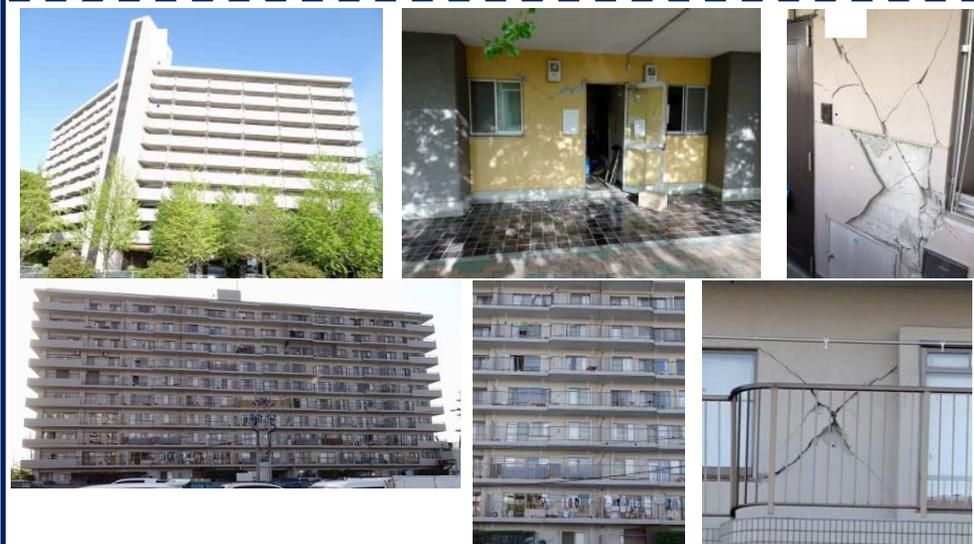
一見、無被害に見えるが、非構造部材に過大な損傷が生じている。
