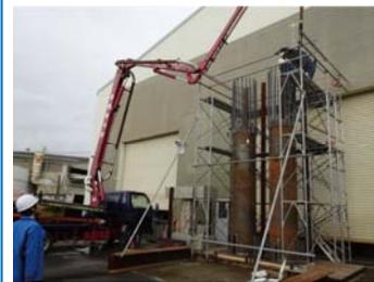
場所打ち鋼管コンクリート杭打設時の様子
