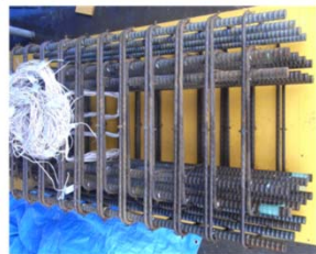
コンクリートに覆われる前の鉄筋
